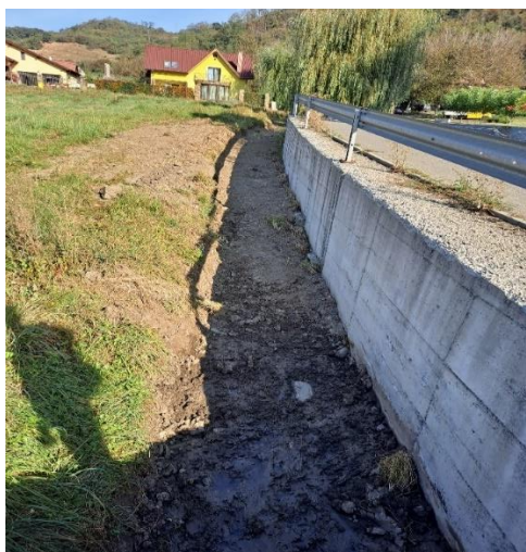
Decolmat șanț str. Câmpul de Sus
