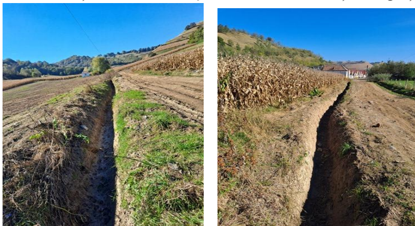
Consolidat mal șanț str. Școlii și confecționat punte pietonală.
