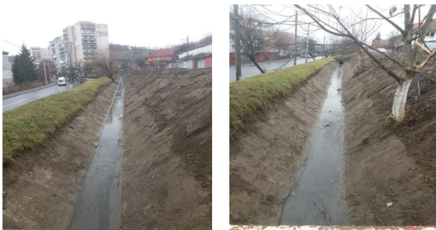
Decolmatare șanturi Ighișul Nou.
